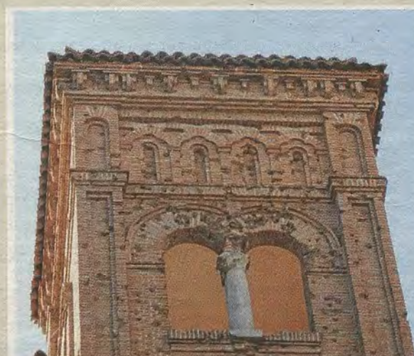
Impactos de metralla en el torreón y detalle de la puerta cerrada
