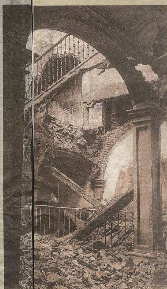
Aspecto de la escalera principal tras el incendio de 1921. Foto Rodríguez
