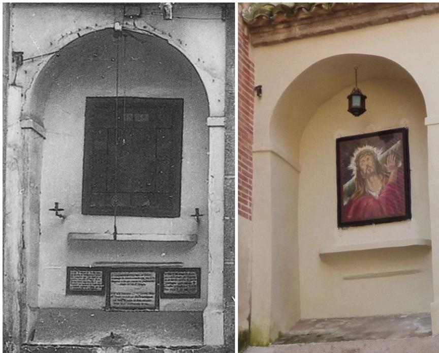
8. Iglesia de San Justo. Detalles para el manejo de los faroles. A la izquierda, el hueco, cuya puerta aparece rota, en 2014, con el anclaje para atar la cuerda y el orificio por el que discurría. A la derecha, una garrucha que atravesaba el cáñamo para sujetar el farol sobre un arco devocional. FOTOS RAFAEL DEL CERRO
