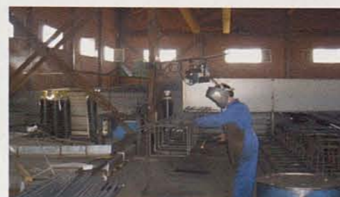
-ELABORACION DE FERRALLA
