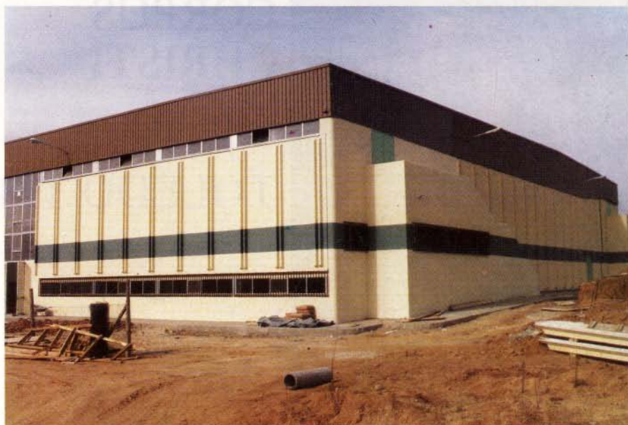
AMPLIACION POLIDEPORTIVO MUNICIPAL "SALTO DEL CABALLO"
